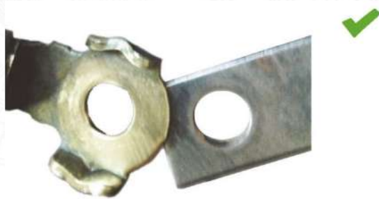
Рис. 2: Подключение заземления после очистки: хороший контакт
