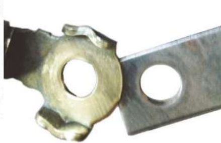
Рис. 2: Подключение заземления после очистки: хороший контакт
